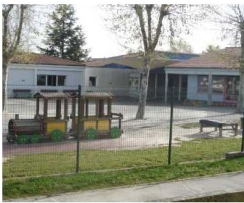
La rénovation complète de l'école maternelle L'Île-Bleue sera le plus gros investissement en 2023. ARCHIVES JEAN-PIERRE NOWAK
